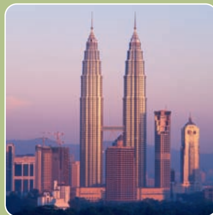
Torres Petronas em Kuala Lumpur
